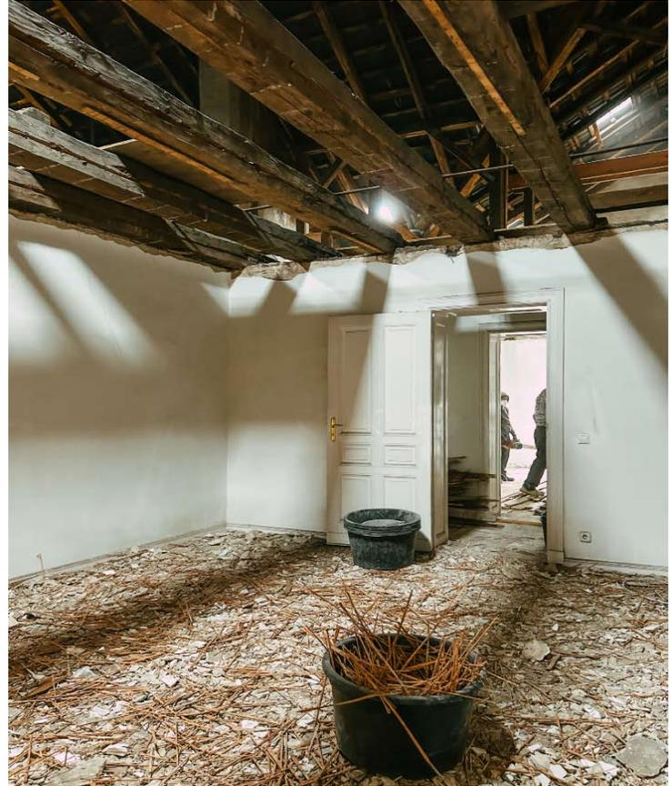
**Die befallenden Deckenbalken wurden entfernt und ersetzt.**
