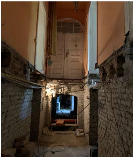
Neusetzen der Kellerdecke
