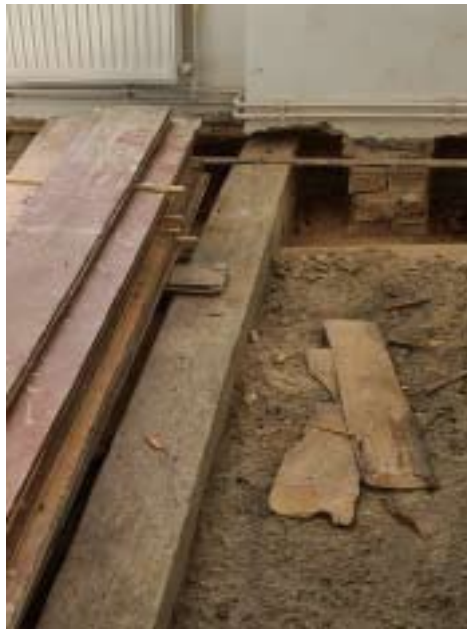
Vorbereitung und Freilegung des Dielenbodens
