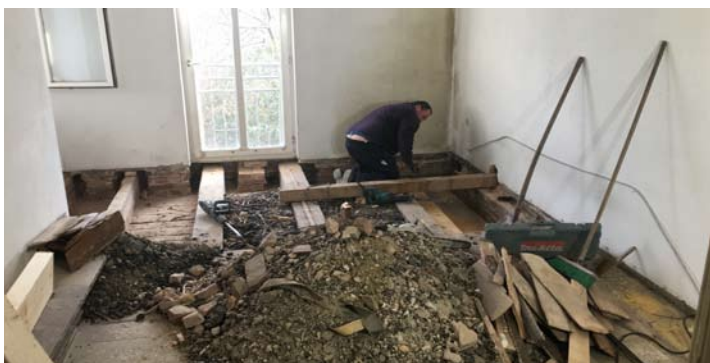
Vorbereitung und Freilegung des Dielenbodens
