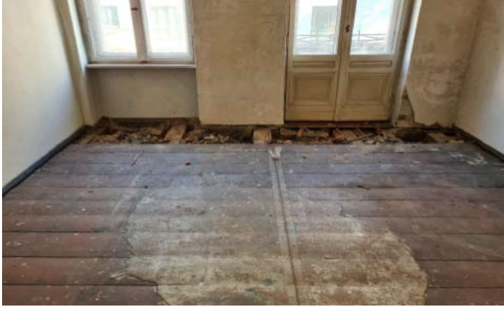
Balken zunächst stark geschädigt
