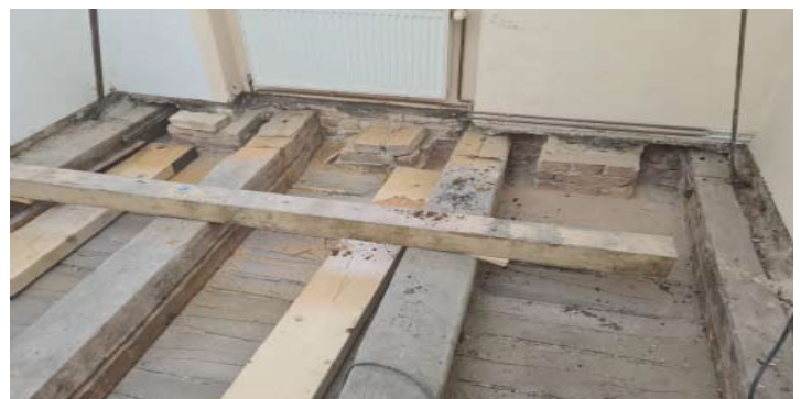
Vorbereitung und Freilegung des Dielenbodens
