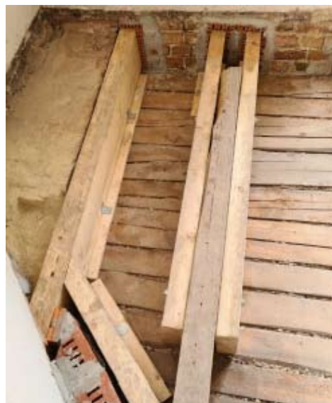
Fixierung und Verstärkung der Holzbalken durch Achsen und Stahlprofil
